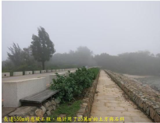
長達550m的慈堤工程，總計用了25萬m<sup>3</sup>的土方與石料
