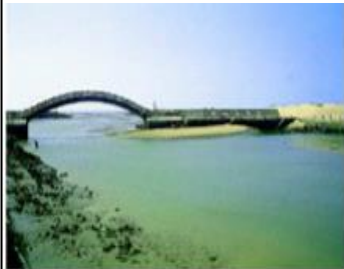
圖4 飛沙越過防波堤並侵入漁港航道(苑裡鎮苑港漁港)。
